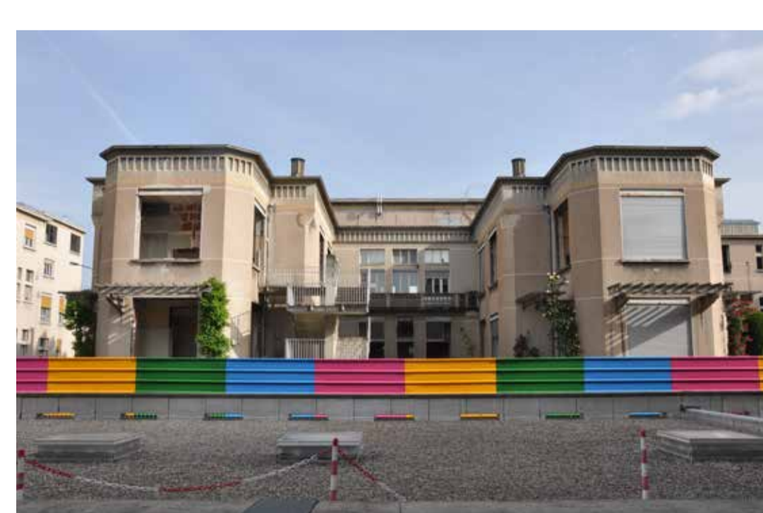
Démolition du pavillon H de l'hôpital Edouard Herriot, architecte Tony Garnier, Lyon 3 e 2015
